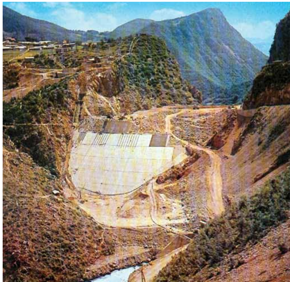
Brana od kamenog nabačaja sa uzvodnim betonskim ekranom
